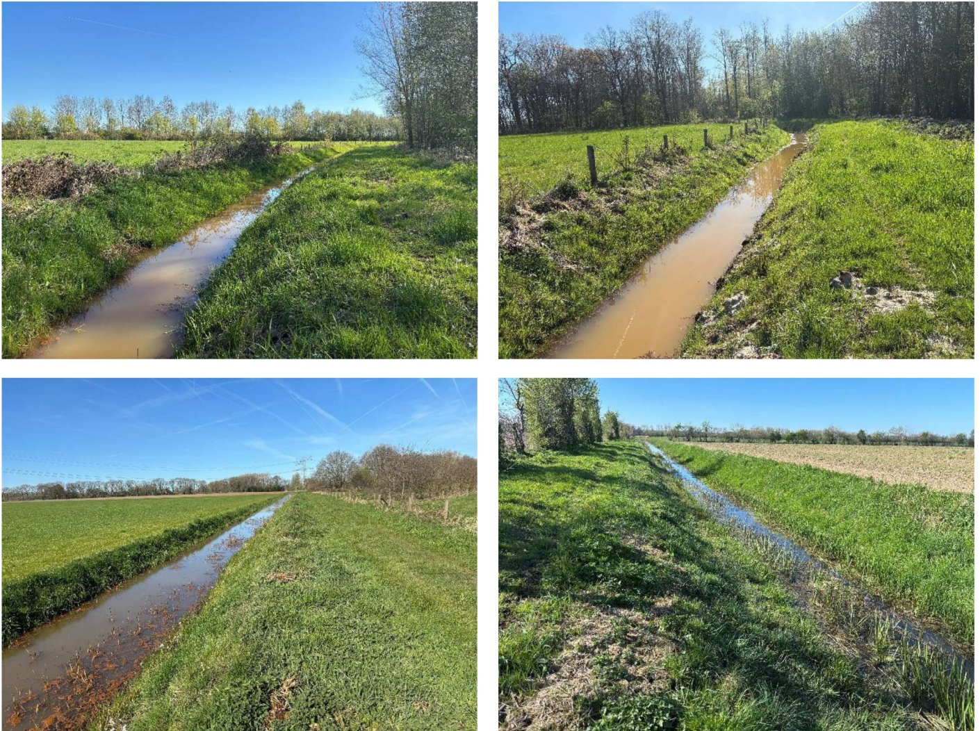
Figuur 5-10 Voorbeelden van oeververruiging bij vier verschillende waterlopen (sloten nabij Beers) (bron: interne communicatie waterschap).
