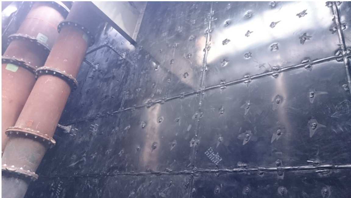
Foto: beschermende platen in stripperput RWZI Dinther
