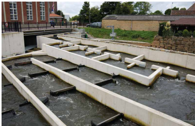
Vispassage ECI waterkrachtcentrale Roermond
