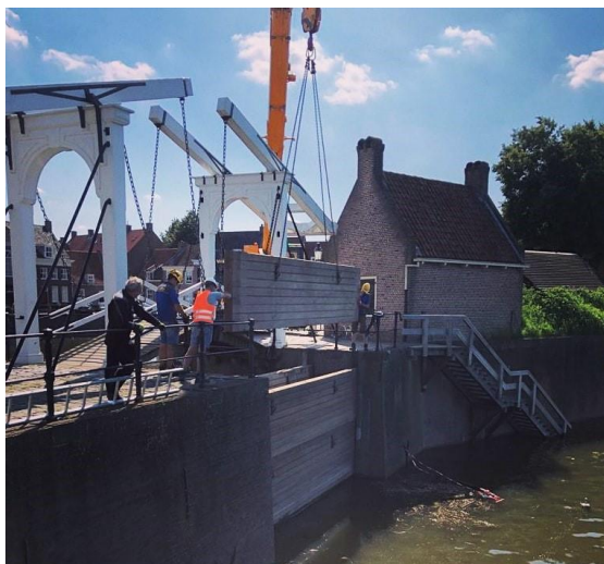
Afbeelding 1.5 en 1.6. Sluiten kunstwerk Heusden haven en noodmaatregel dempen teensloot bij Doeveren
