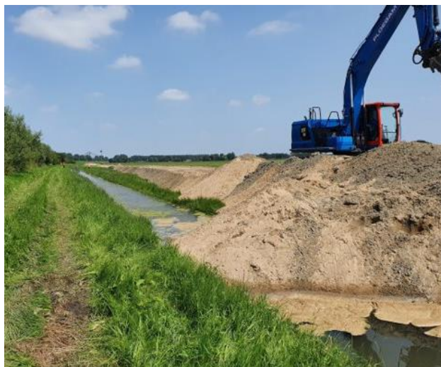
Afbeelding 1.5 en 1.6. Sluiten kunstwerk Heusden haven en noodmaatregel dempen teensloot bij Doeveren
