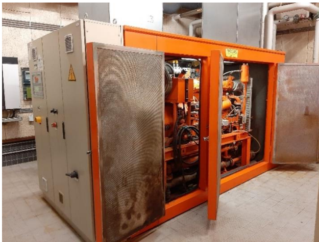
Gasmotoren: einde technische levensduur, onderdelen niet meer verkrijgbaar, voldoet niet meer aan huidige veiligheidsnormen
