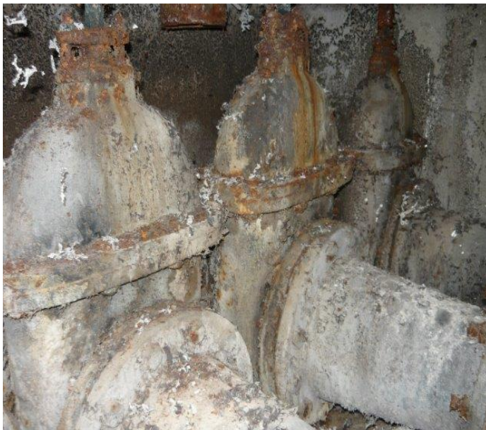
Voorbeelden vervangen niet gangbare afsluiters
