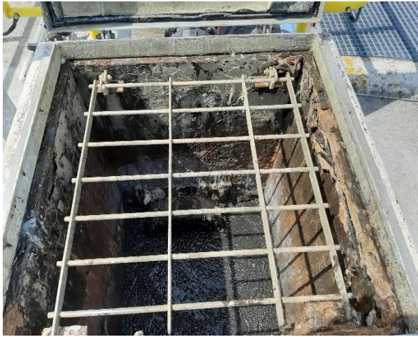
Voorbeelden vervangen betonrot en leidingwerk
